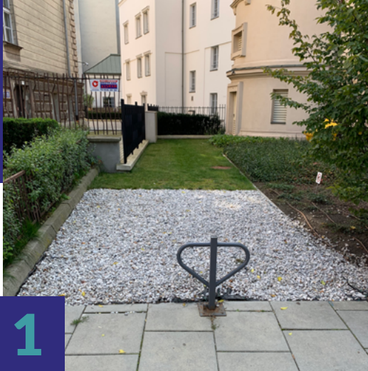
Przydomowe miejsce postojowe wypełnione grysem (fot. RetencjaPL)
