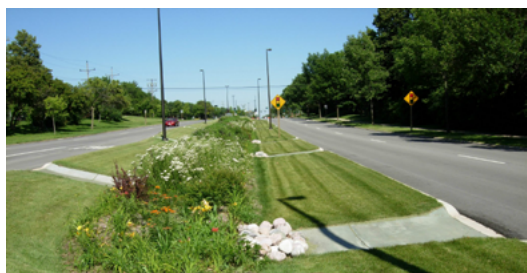
Odwodnienie, ozdoba zieleni i separacja jezdni w jednym (fot. Aaron Volkening, CC BY 2.0)
