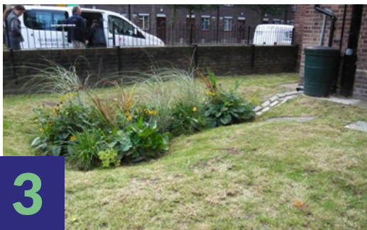
Ogródek deszczowy zatrzymuje i podczyszcza wodę (fot. susdrain.org)
