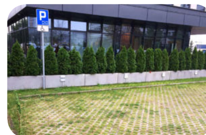
fot. 1. Parking z prefabrykatów betonowych. /Jacek Zalewski, RetencjaPL/
