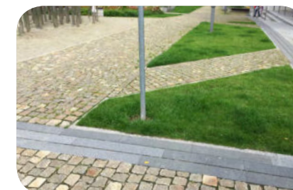
fot. 18. Dzięki niskim krawężnikom woda podlewa bujną trawę. /Jacek Zalewski, RetencjaPL/
