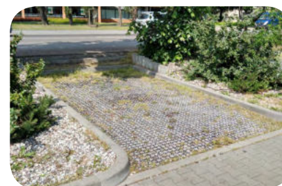
fot. 3. Parking z geokrata wypełnioną kruszywem i utwardzonymi przejazdami. /Urząd Miasta Sopotu/
