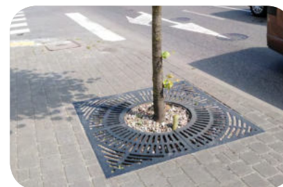
fot. 13. Krata dookoła drzewa zapewnia wsiąkanie, ale też chroni przed ubiciem ziemi.
