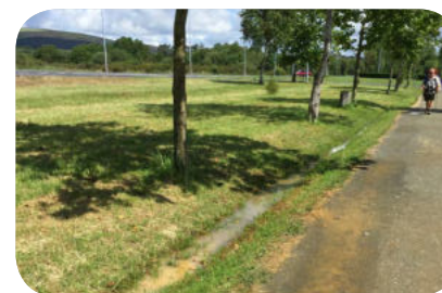
foto. 33. Przydrożna mulda opóźnia odpływ deszczówki, a woda podlewa drzewa.
