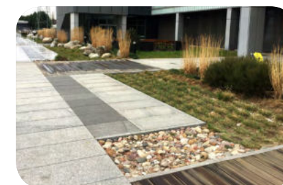
fot. 8. Plac przed biurowcem. Swobodny spływ deszczówki z płyt betonowych umożliwia jej wsiąkanie. /Jacek Zalewski, RetencjaPL/
