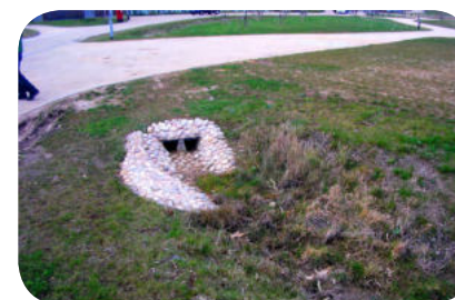
fot. 27. Wylot z systemu deszczowego do niecki chłonnej. /Tomasz Glixelli, RetencjaPL/
