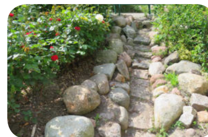
fot. 23. Odprowadzenie wody deszczowej z alejek spacerowych. /Urząd Miasta Sopotu/
