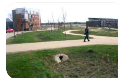
foto. 34. Niecka chłonna z przepustem pod nieuszczelnioną ścieżką. Wielka Brytania.
