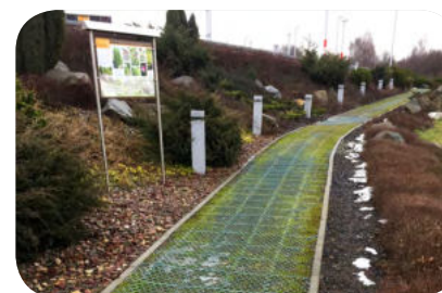
fot. 7. Ścieżka z lekkiej geokraty, z niskimi krawężnikami.
