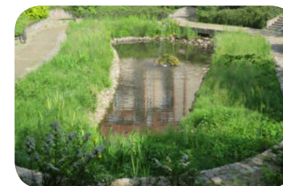
fot. 48. Zbiornik retencyjny Kochanowskiego będący jednocześnie ogrodem deszczowym
